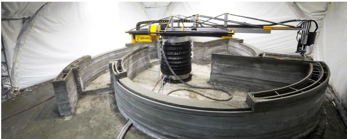
Slika 2.4. Mobilna konstrukcija 3D printera [15]
