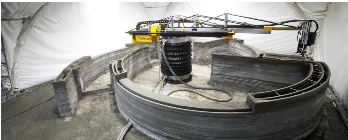
Slika 2.4. Mobilna konstrukcija 3D printera [15]
