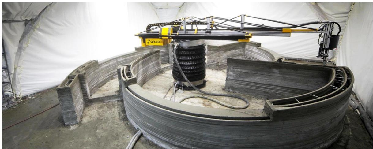
Slika 2.4. Mobilna konstrukcija 3D printer-a [15]
