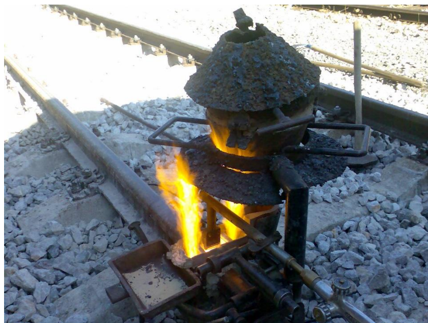
Slika 5.6. Predgrijavanje kalupa plinskim plamenom
