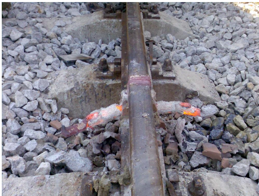
Slika 5.12. Tračnica nakon uklanjanja viška materijala
