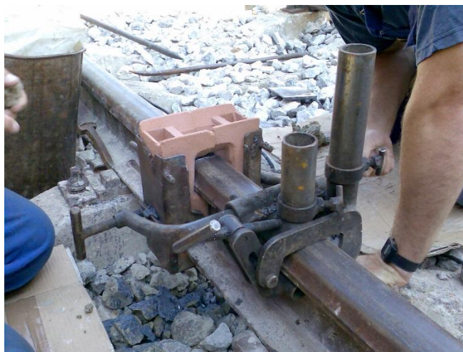
Slika 5.2. Namještanje kalupa i nosača tigl lonca
