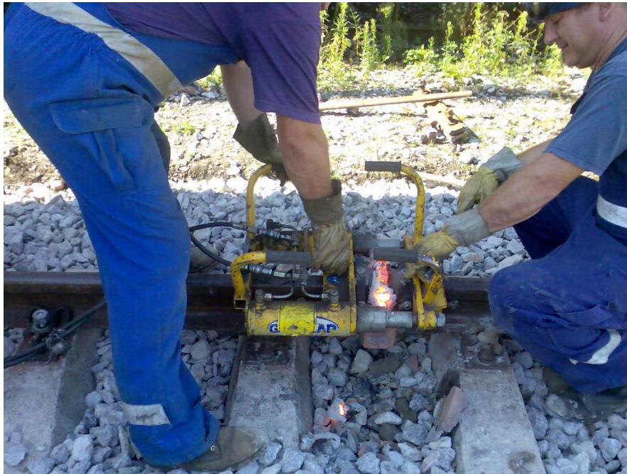
Slika 5.11. Uklanjanje viška materijala hidrauličnim trimerom
