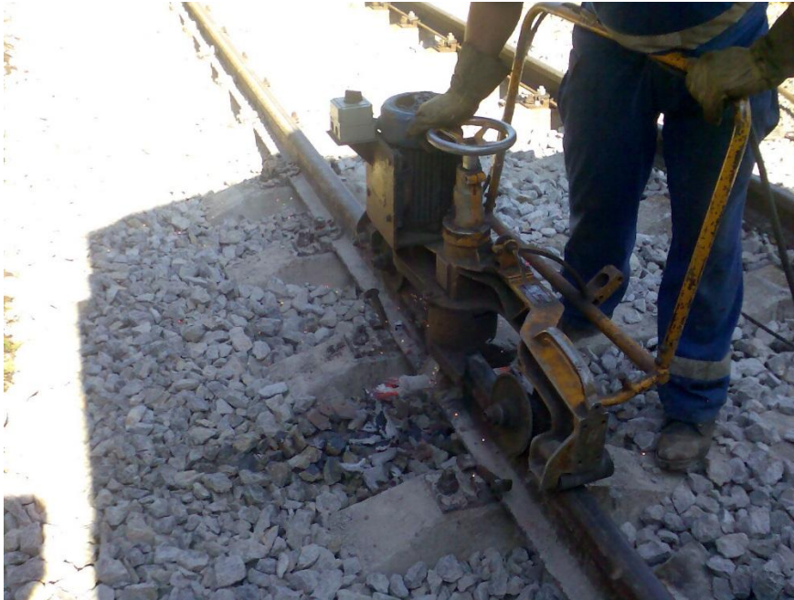
Slika 5.13. Završno brušenje zavarenog spoja
