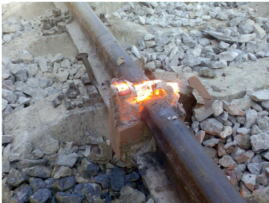
Slika 5.10. Razbijanje kalupa
