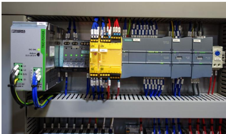
Slika 1.4. PLC moduli
