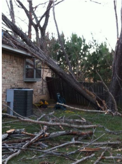
Slika 2.21. Stablo koje se uslijed nevremena srušilo na kuću.
