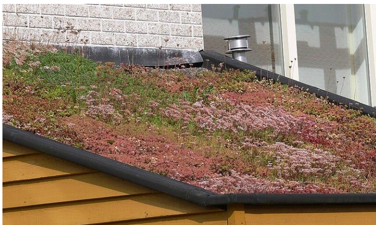
Slika 2.4. Ekstenzivni zeleni krov.
