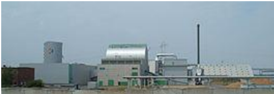
Slika 2.1 Kogeneracijsko postrojenje u Danskoj
