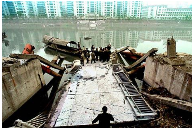
Slika 6.3. Prikaz mosta nakon rušenja [19]
