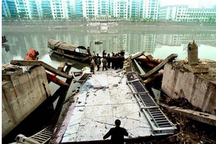
Slika 6.3. Prikaz mosta nakon rušenja [19]
