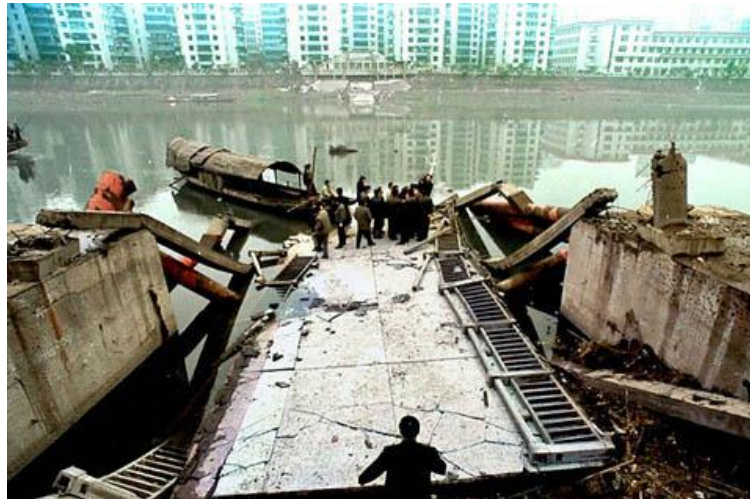
Slika 6.3. Prikaz mosta nakon rušenja [19]
