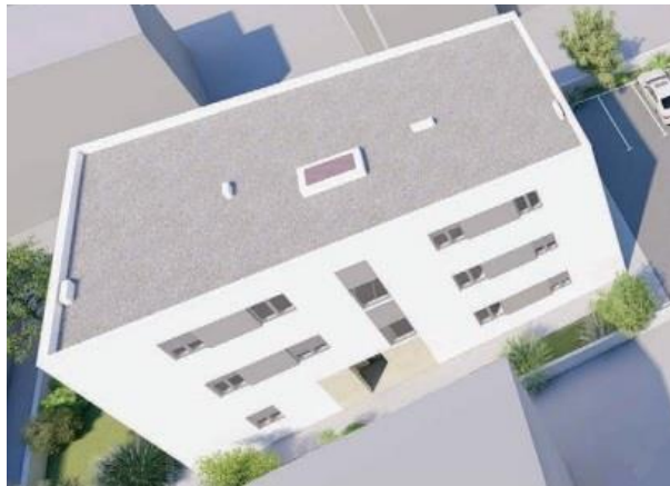
Slika 7. Krov višestambenog objekta predviđen za instalaciju fotonaponske elektrane Izvor: https://eurogradnja.hr/kompleks-stambenih-zgrada-u-predjelu-smiljevca/
