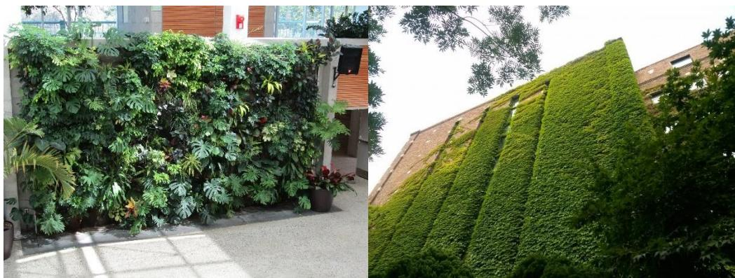
*Slika 2.8. Unutrašnji zeleni zid i vanjska zelena fasada.*
