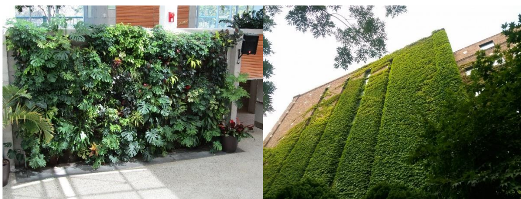
Slika 2.8. Unutrašnji zeleni zid i vanjska zelena fasada.
