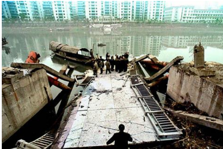
Slika 6.3. Prikaz mosta nakon rušenja [19]
