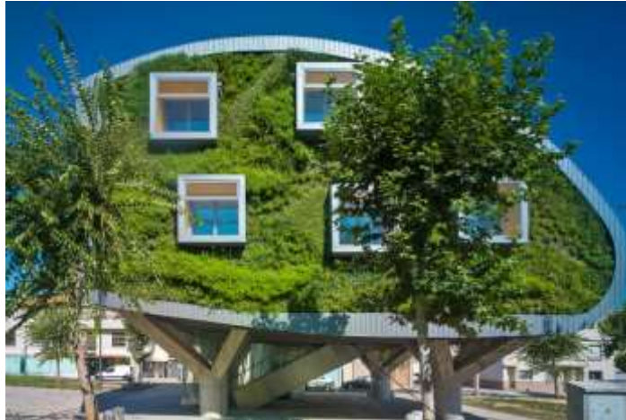
Slika 4. Kuća s nultom potrošnjom energije
