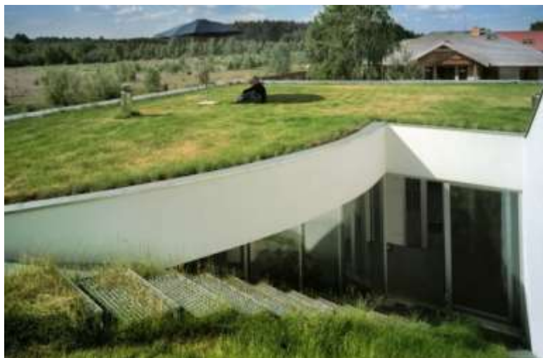
Slika 16. Zeleni krov kuće OUTrial u Poljskoj
