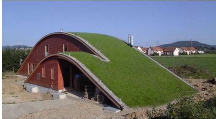
Slika 8. Vrsta krovova koja spada u skupinu poluintenzivni sustavi
