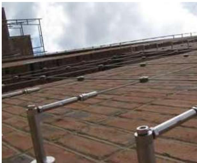
*Slika 15. Kabelski sustavi koriste priključke na svakom sjecištu vertikalnih kabela i vodoravne šipke*
