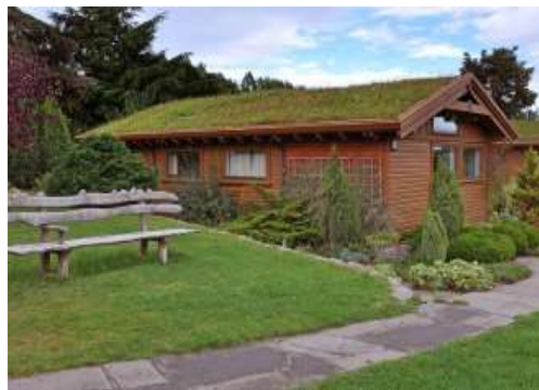
Slika 7. Vrsta krovova koja spada u skupinu Opsežni sustav
