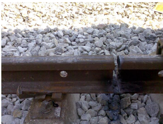
Slika 5.1. Poravnavanje tračnica
