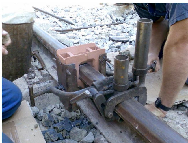
Slika 5.2. Namještanje kalupa i nosača tigl lonca
