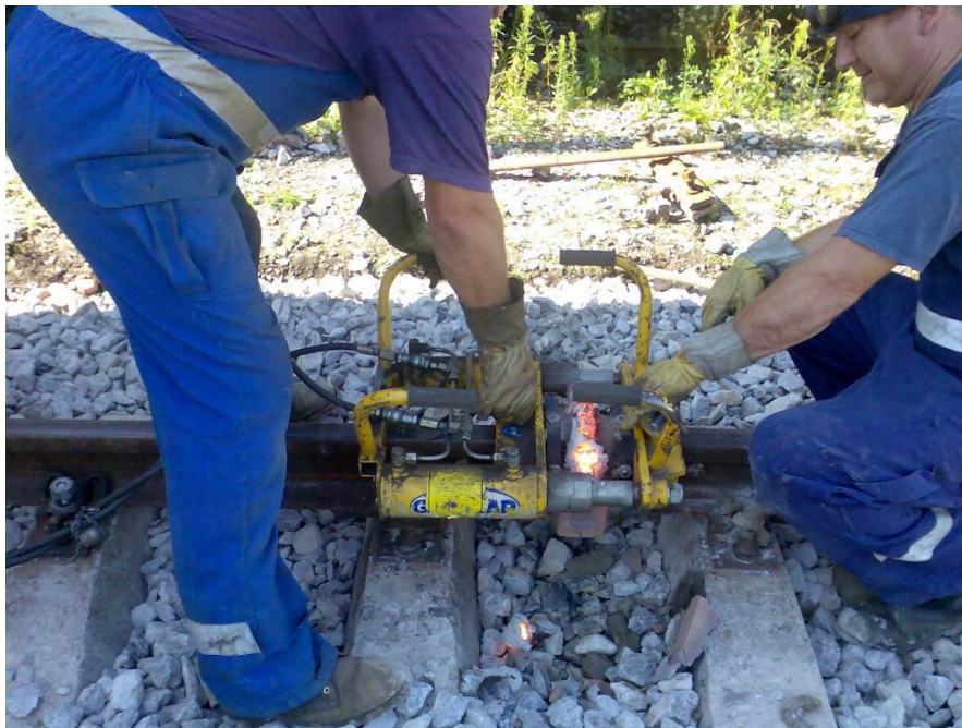
Slika 5.11. Uklanjanje viška materijala hidrauličnim trimerom
