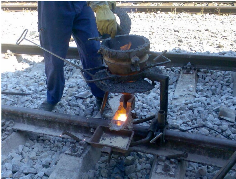
Slika 5.7. Prikaz paljenja termitne smjese
