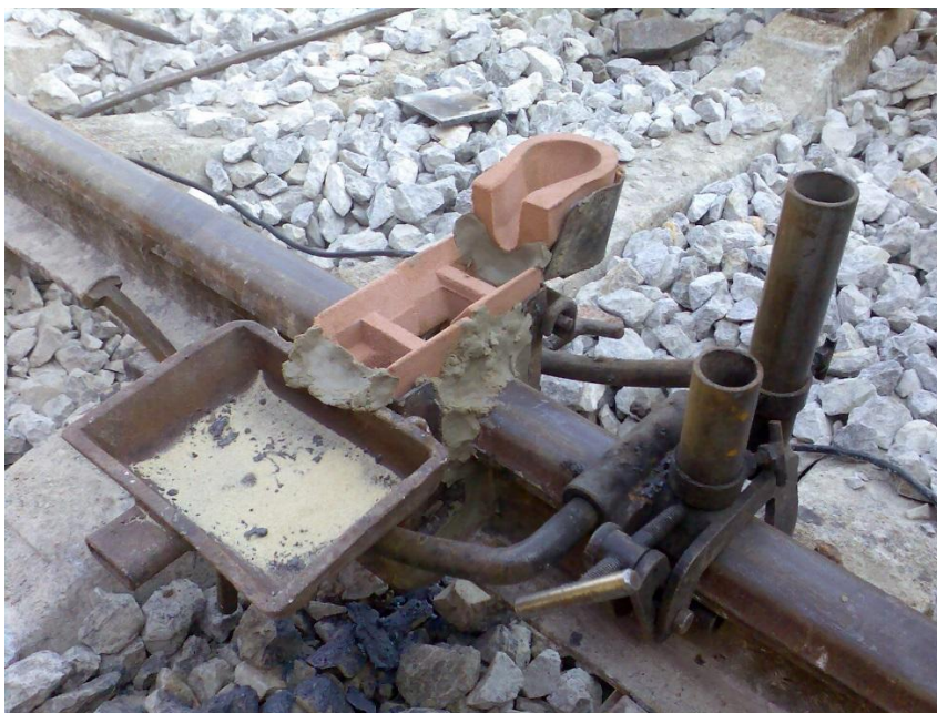
Slika 5.4. Izgled kalupa nakon završenog nanošenja gline
