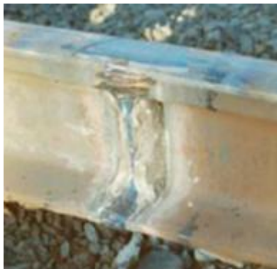
Slika 4.14. Izgled završnog spoja tračnice [12]
