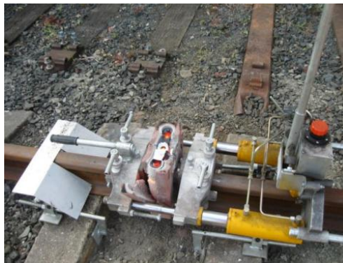
Slika 4.12. Hidrulični trimmer za skidanje viška materijala [17]
