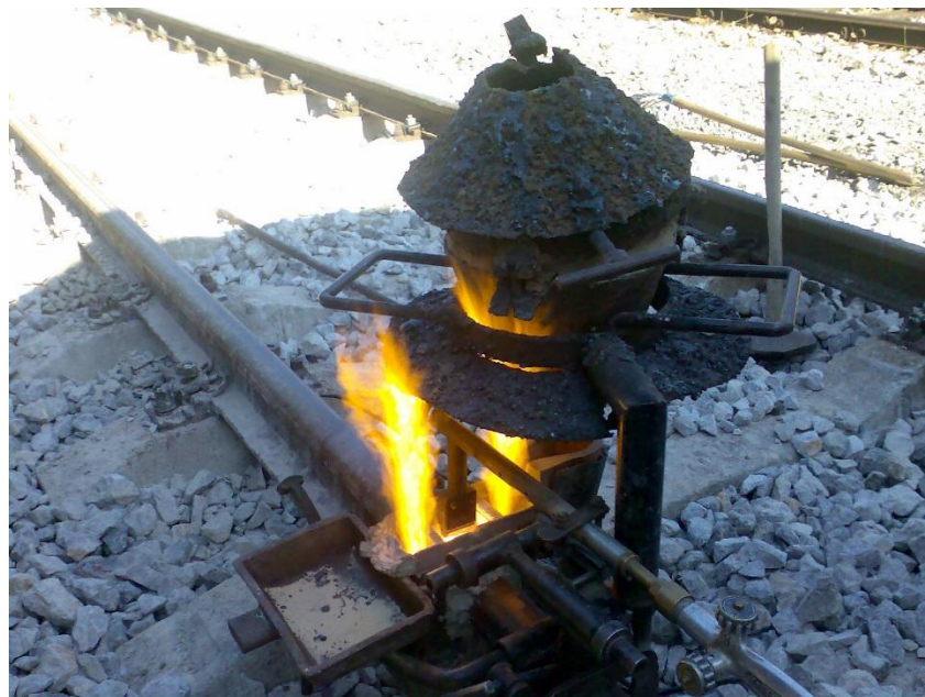
Slika 5.6. Predgrijavanje kalupa plinskim plamenom
