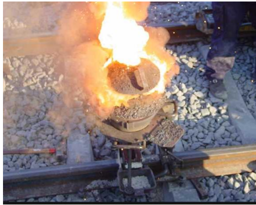
Slika 4.11. Reakcija zapaljenja termitne smjese [20]
