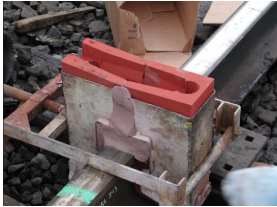
Slika 4.9. Prikaz sastavljenog kalupa za ulijevanje [19]
