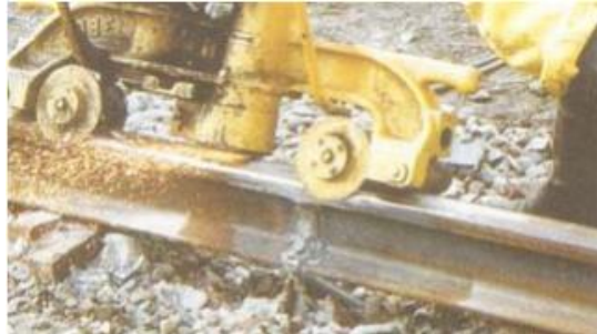
Slika 4.13. Brusilica za završnu obradu zvara [9]
