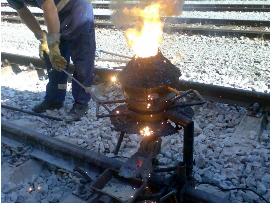
Slika 5.8. Aluminotermijska reakcija
