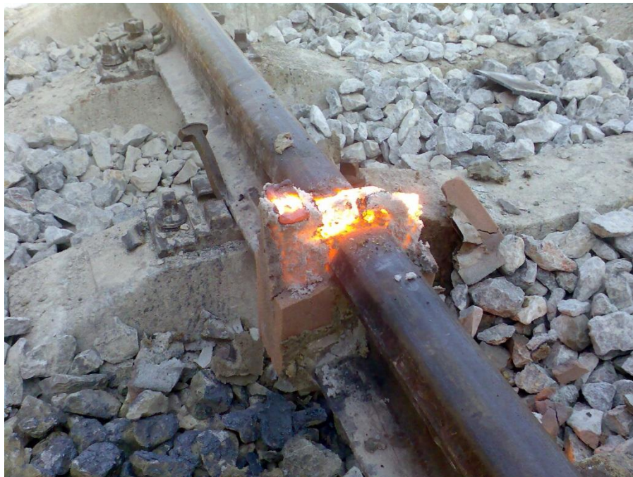
Slika 5.10. Razbijanje kalupa
