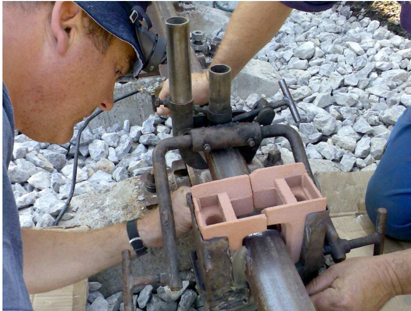
Slika 5.3. Nanošenje gline na kalup
