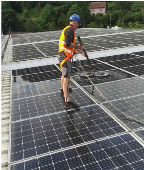
*Slika 3. Čišćenje fotonaponski modula
