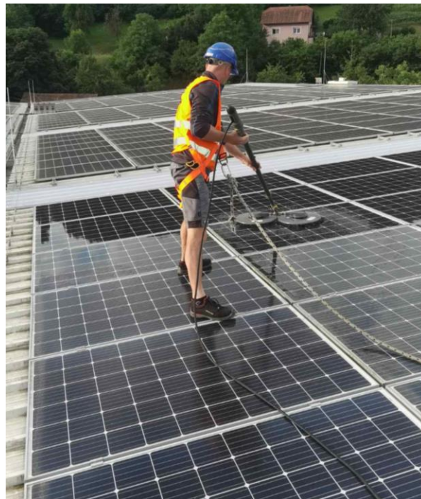
Slika 3. Čišćenje fotonaponski modula Izvor: Vlastita arhiva
