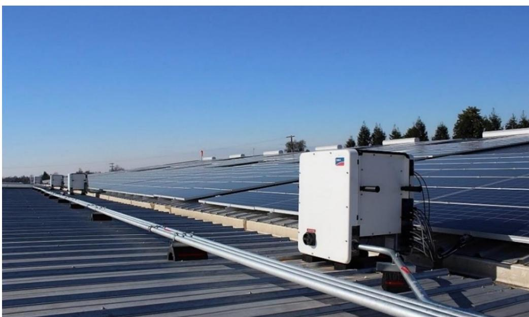
Slika 2. Fotonaponski izmjenjivač
