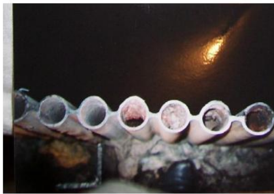
6.9. Naslage kamenca u cijevima
