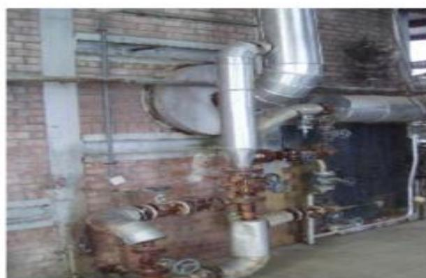
Slika 6.2. Pomoćni cjevovodi kotlovnog sustava
