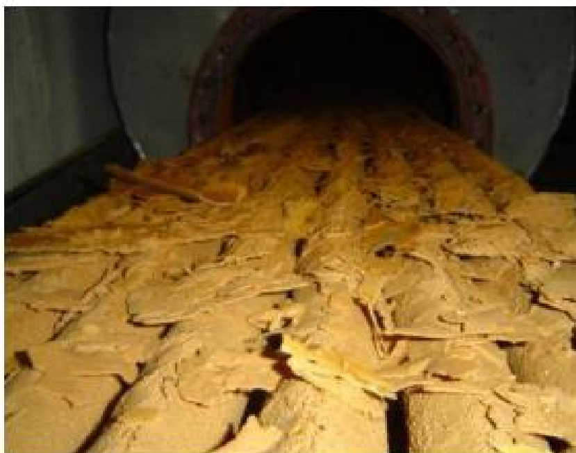
Slika 6.7. Cijevi prije kemijskog čišćenja
