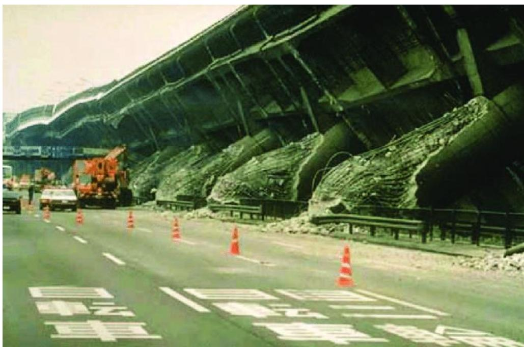
Slika 6.4. Prikaza oštećenih stupova vijadukta [20]
