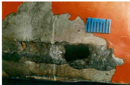
Slika 5.9. Stvarni prikaz oštećenja selektivnom korozijom [16]
