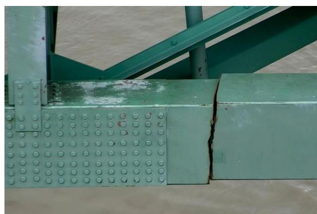
Slika 6.2. Pukotina čelične konstrukcije na mostu
